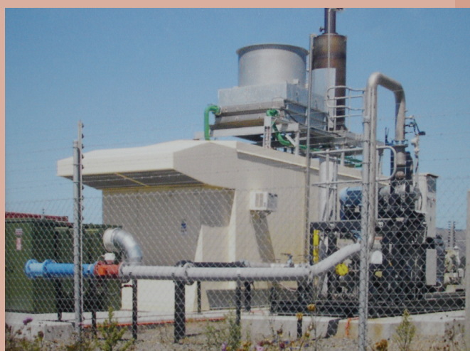
Ka tahuna te haurehu mewaro kia puta ai te hiko. Ko te "Cogene Plant" tēnei mīhini.
